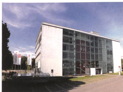
SVTI-Sitz in Wallisellen, dem Standort des neuen Instituts für Werkstofftechnologie IWT. Siège de l'ASIT à Wallisellen, site du nouvel Institut de technologies des matériaux IWT.
