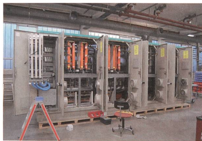
Schaltschrankmontage bei der Firma Simatex.
