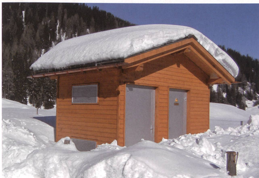
Bild 1 Fabrikfertige Station Typ Dentra mit an örtliche Gegebenheiten angepasster Ausstattung.
