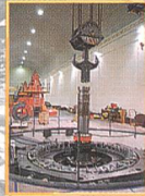
Kraftwerk-Retrofit und Neubau
