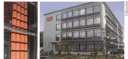
Neues SFS-Gebäude mit Dätwyler-Verkabelung.
