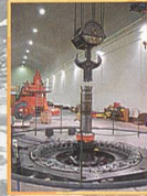
Kraftwerk-Retrofit und Neubau
