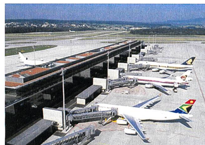
Bild 1 Der neue Terminal E des Flughafens Zürich, wo 440 Fundationspfähle rund 30 m tief reichen (310 zur Energiegewinnung).
