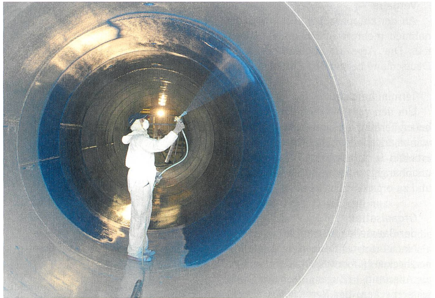
Bild 3 Applikation der zweiten Schicht Humidur in der Lindau-Überleitung.
