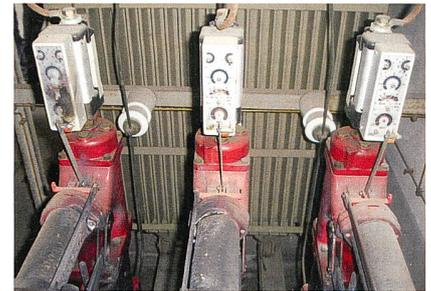
**Bild 3** Brandspuren eines 3-poligen Kurzschlusses in einer Mittelspannungszelle, ausgelöst durch Eindringen in die Annäherungszone durch den Verunfallten. Er erlitt dabei schwere Verbrennungen, da er die persönliche Schutzausrüstung nicht verwendete.
