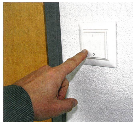
Die eingesetzten Stand-by-Stromschalter (Funkbusssystem Ratio) sind batterieles.
