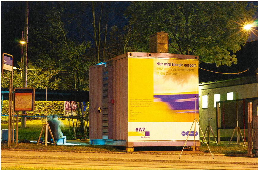
Die Messung der Schallemissionen wurde nachts in Zusammenarbeit mit der Empa durchgeführt.
