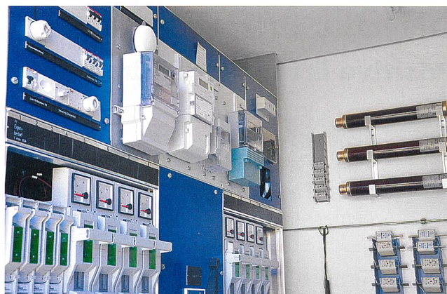
Die Datenkonzentratoren in den acht Transformatorstationen (hier links neben dem E350-Zähler) sammeln die Daten der Zähler.
