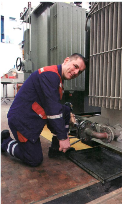
Die Regeneration geschieht vor Ort – ein Transport des Transformators erübrigt sich.
