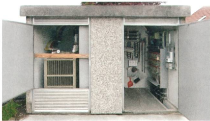
Transformatorstation vor dem Umbau
