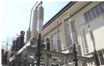
ESF und EST für Spannungsebenen von 52 kV bis 170 kV
