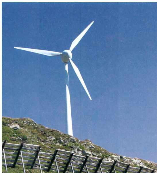
Bild 1 Die erste, 2004 auf dem Gütsch erbaute Windkraftanlage leistete bisher zuverlässige Dienste.
