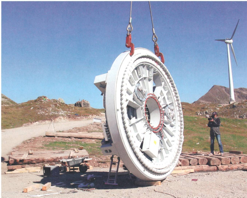
Bild 3 Der 0,9-MW-Generator der neuen Gütsch-Windkraftanlage.
