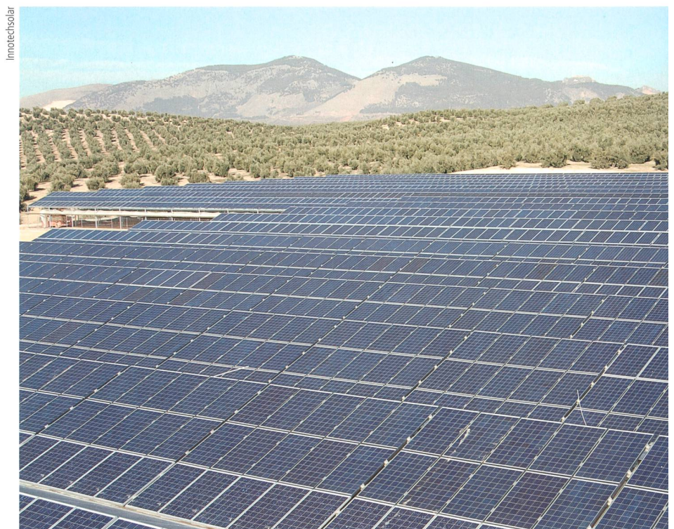
4,3-MW-Fotovoltaikanlage bei Granada, Spanien. Die Anbindung von Fotovoltaikanlagen an bestehende Netze ist anspruchsvoll.
