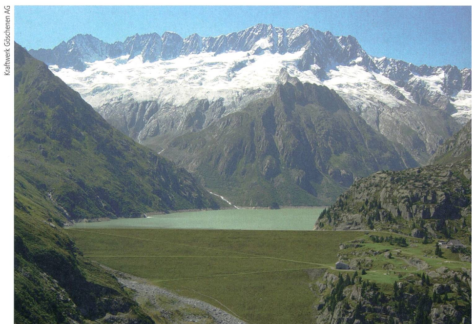
Bild 1 Staudamm Göschenalp: Die Erhöhung scheiterte, da keine Einigung über die Restwertvereinbarung am Konzessionsende zustande kam.
