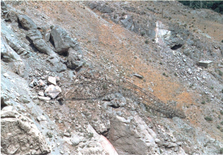
Bild 7 Zerstörte Hochspannungslleitung der Sefid-Rud-Stauanlage (Manjil-Erdbeben 1990, Iran).
