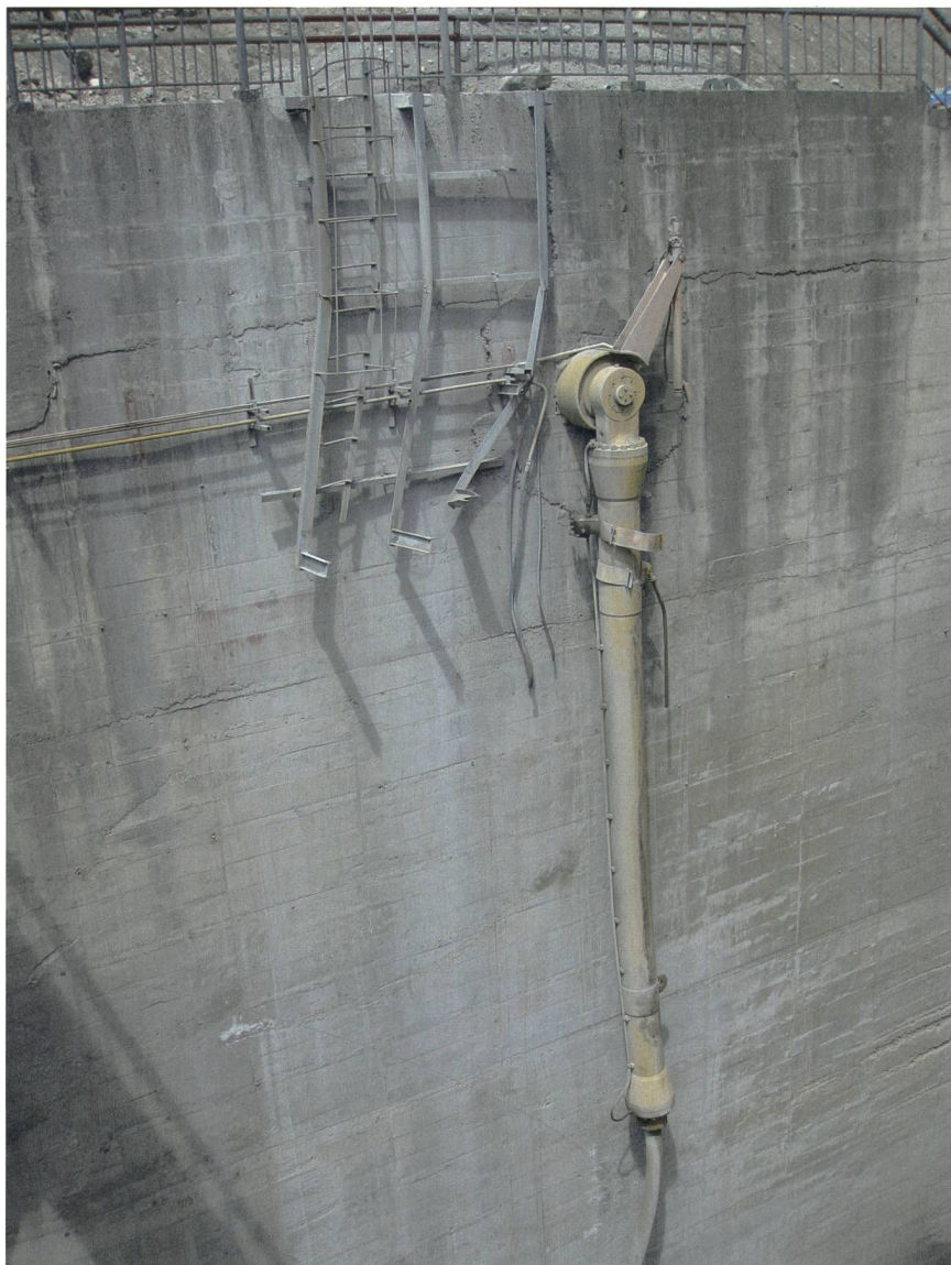
Bild 3 Durch Steinschlag zerstörte und weggeschwemmte Schütze eines Flusskraftwerks; nur der Hydraulizylinder ist übrig geblieben (Wenchuan-Erdbeben 2008, Sichuan, China).
