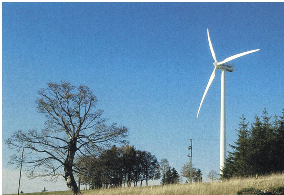
Les progrès techniques confèrent aujourd'hui fiabilité et performance aux énergies renouvelables.
