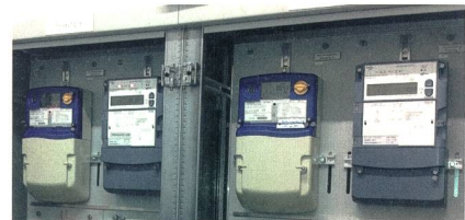
Der AS1440 als Lastgangzähler mit Wandleranschluss – die Einbindung in bestehende Infrastruktur ist problemlos möglich.
