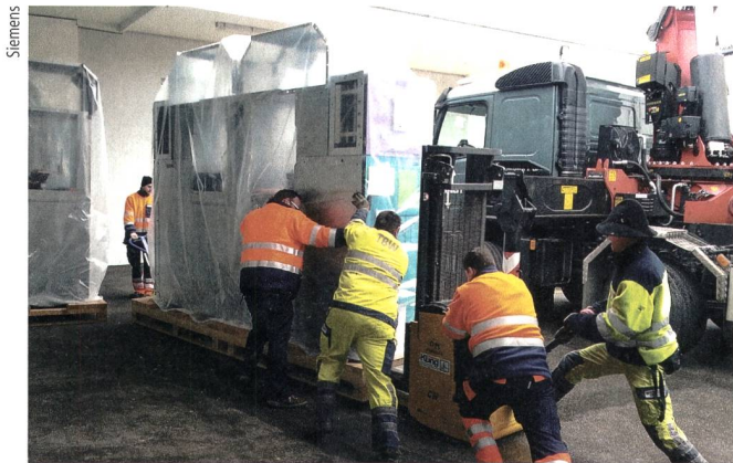
Bild 4 Anlieferung der Schaltfelder.
