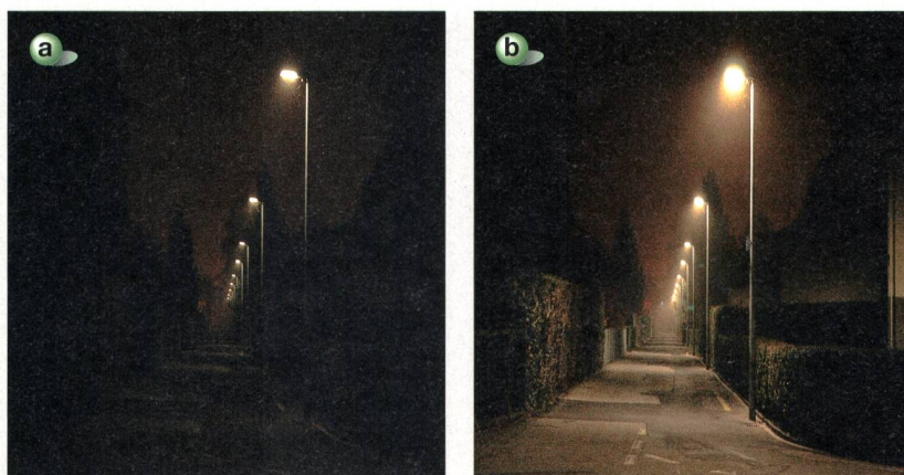
Figure 2 Fonctionnement à 20 % (a) et à 100 % (b).
