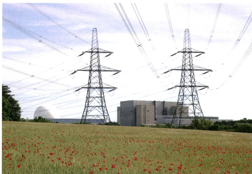
Bild 1 Hinsichtlich der Kernenergie besteht in Grossbritannien weitgehend politische Einigkeit. Im Bild: Kernkraftwerk Sizewell an der englischen Ostküste. Die Anlage A (rechts) wurde 2006 stillgelegt, der Druckwasserreaktor in Anlage B (links) ist noch in Betrieb.
