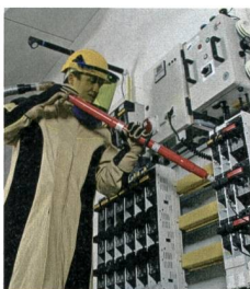
Aktiver Störlichtbogenschutz mit DEHNarc.
