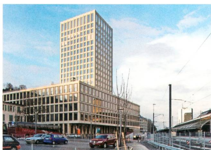
Fachhochschulzentrum in St. Gallen nutzt Klasse-FA-Verkabelungssystem von Dätwyler.
