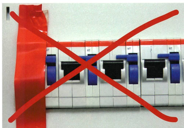
Figure 2 Recouvrir d'un ruban adhésif n'est pas une protection suffisante contre le réenclenchement.
