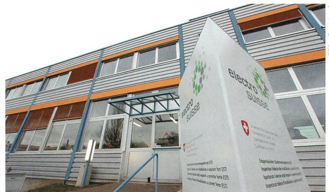
Betriebsgebäude am Standort Rossens.
