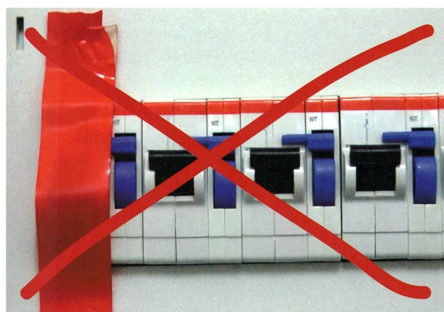
Bild 2 Mit Klebeband abkleben, reicht nicht für Schutz gegen Wiedereinschalten.
