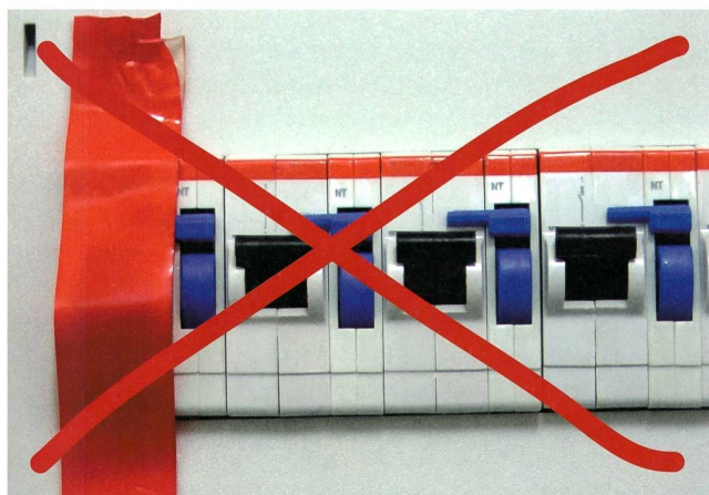
Figura 2 Per garantire la protezione contro il reinserimento, non basta bloccare gli interruttori protettivi di linea in posizione «disinserito» con del nastro adesivo.
