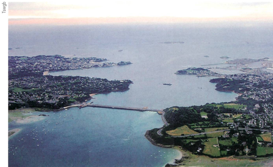
Bild 2 Der 750 m lange Damm des Gezeitenkraftwerks Rance sorgt schon seit fast 50 Jahren für eine zuverlässige erneuerbare Stromerzeugung.
