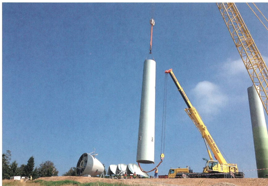
Bild 2 Der Bau von Windkraftanlagen im Gebirge bringt besondere Herausforderungen mit sich.
