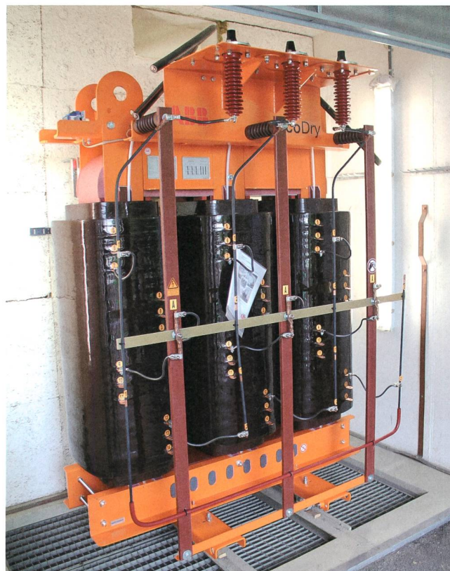
Bild 7 Amorpher EcoDry Trockentransformator, im Unterwerk Fällanden seit 2010.
