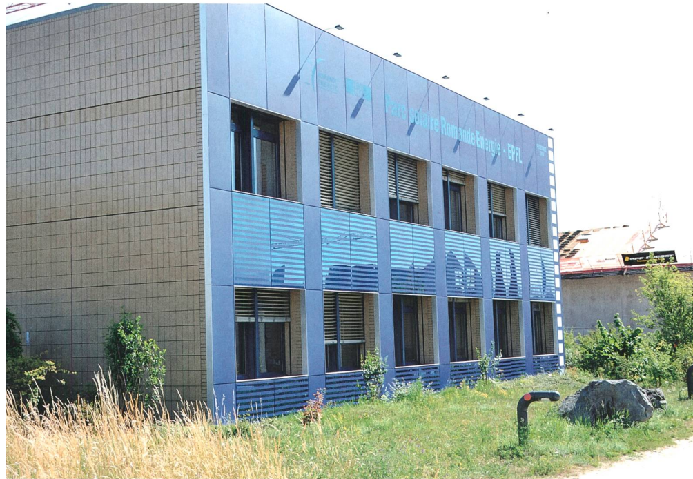
Als dezentraler Stromerzeuger ist die PV-Fassade eine Komponente des an der ETH Lausanne erforschten Smart-Grid-Konzepts.
