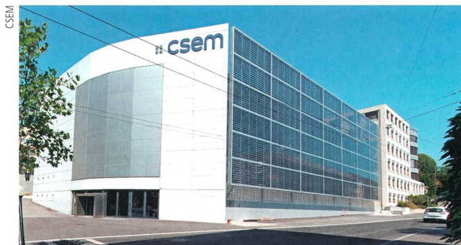
La semi-transparence de la façade confère une impression de légèreté à l'ensemble du bâtiment.
