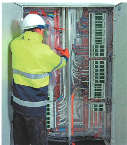
Travaux sous tension.
