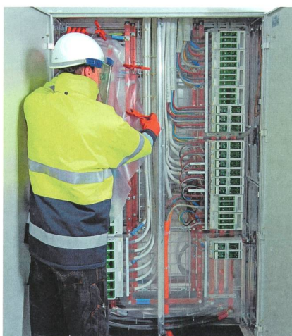
Arbeiten unter Spannung.
