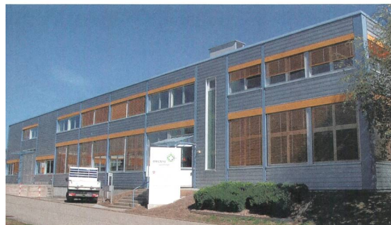
Le laboratoire de Rossens, Electrosuisse Romandie, ainsi que l'Inspection fédérale des installations à courant fort (ESTI) sont regroupés sous un même toit depuis fin 2014.
