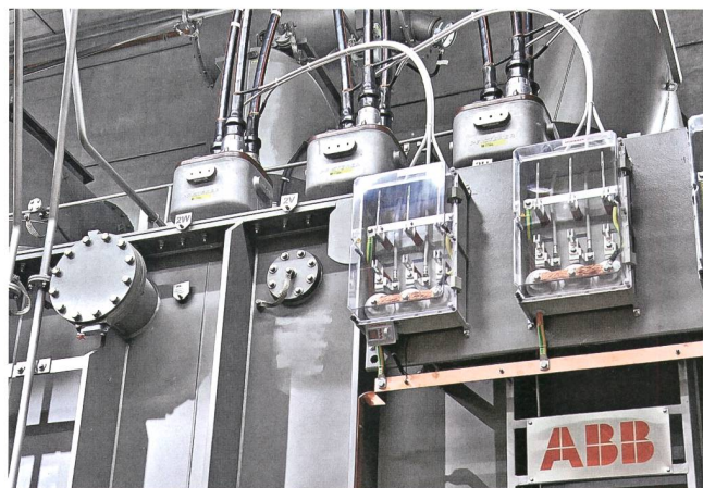
Die neuen MV-Connex-Transformatoren-Anschlusssteile von Pfisterer (obere Bildmitte) für bis zu 2200 A respektive 3150 A je nach Anschlussart und bis zu 52 kV ermöglichen den hochkompakten Mehrfach-Anschluss von vertikal geführten MV-Kabeln – hier im Einsatz mit Erdtrennerkästen für die effiziente Schirmbehandlung und DSA-i3-Dauerspannungsanzeige-Geräten von Pfisterer.
