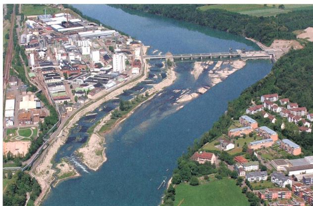
Bild 3 Das Laufwasserkraftwerk Rheinfelden wurde in den Jahren 2003 bis 2010 modernisiert.
