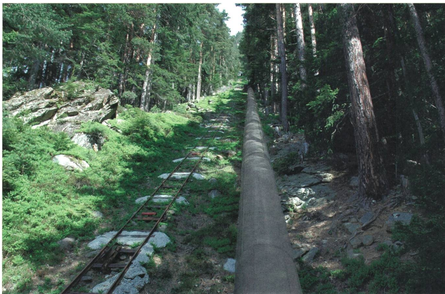
Bild 2 Die zu ersetzende Druckleitung.
