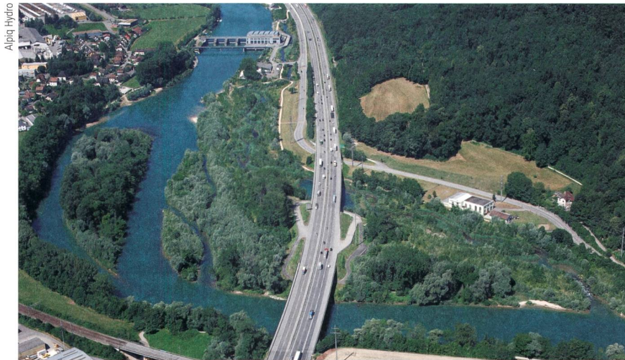
Bild 2 Das Kraftwerk Ruppoldingen ist eine der grössten mit Naturemade Star ausgezeichneten Anlagen der Schweiz.
