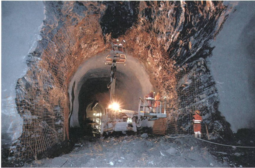
Ausbau der Kaverne.
