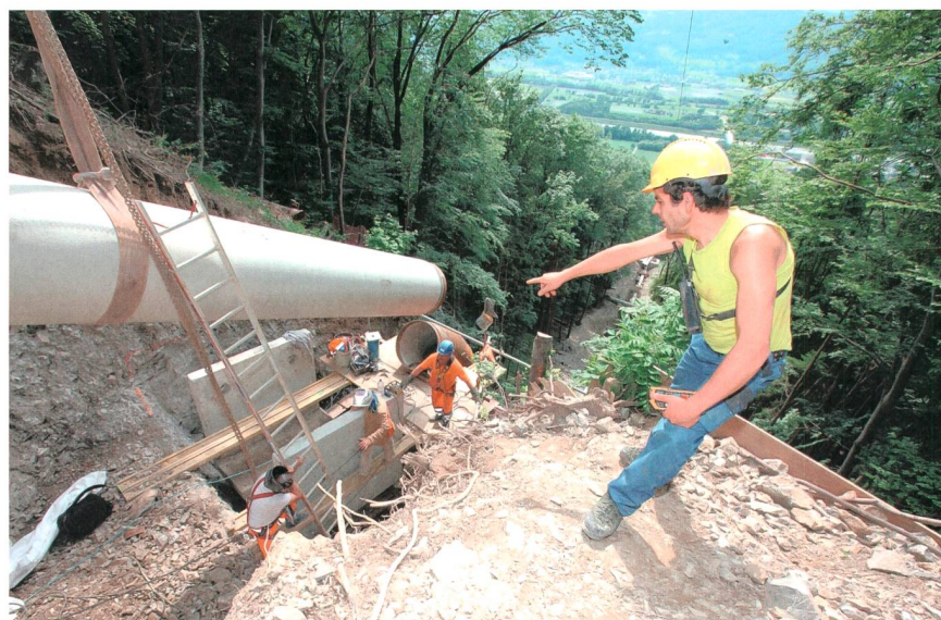
Druckleitungsverlegung am Hang.
