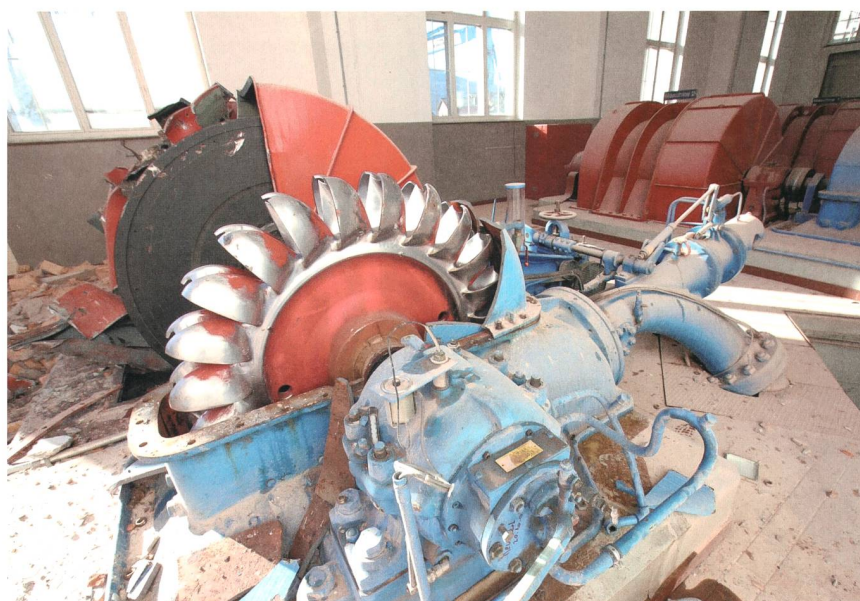
Demontagearbeiten im alten Kraftwerk.
