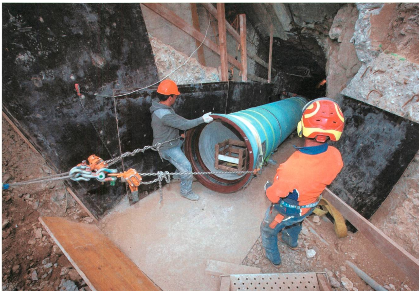
Einbau der neuen Druckleitung in den fast 2 km langen Stollen.
