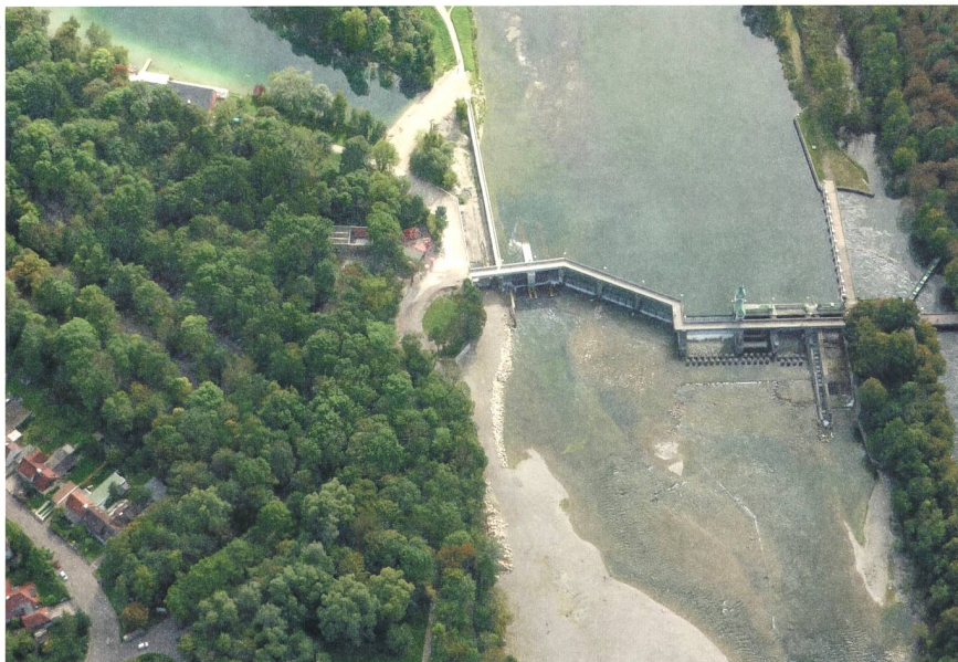
Bild 6 Wehranlage Hochablass am Lech in Augsburg, im linken Bereich die überflutete Anlage. Inbetriebnahme 2013, 2 Maschinensätze, Ausbauleistung 3,1 MW. [11]
