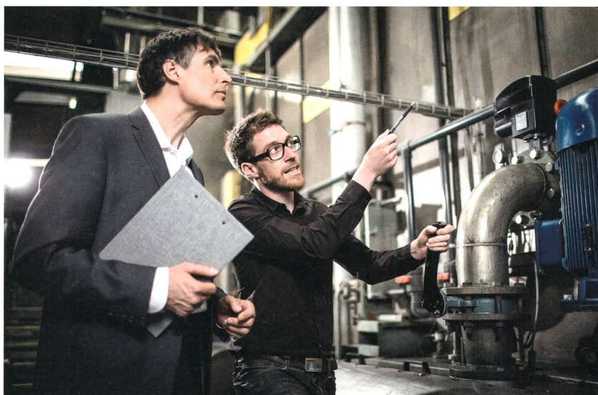
Bild 1 Bei einer Betriebsbegehung werden die wichtigsten Energiedaten erfasst.
