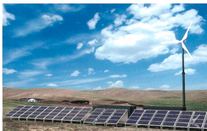
H.P.G.S. ermöglicht eine zuverlässige dezentrale regenerative Stromversorgung.
