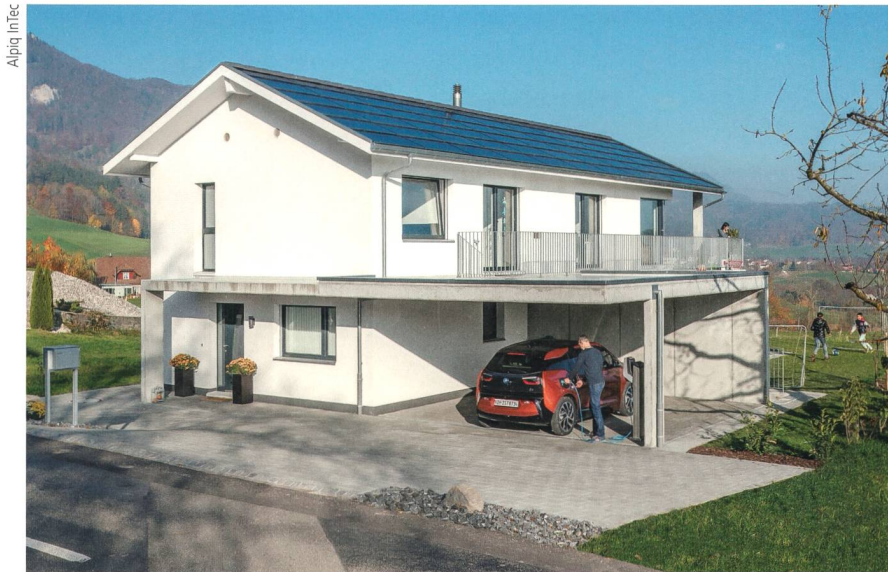
Bild 2 Eines der 40 Einfamilienhäuser im solothurnischen Riedholz, wo in einem Pilotversuch getestet wird, wie sich die Belastung des Verteilnetzes dank «kluger» Steuerung der Verbraucher optimieren lässt.
