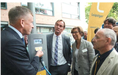
Einweihung der Strassenlaternen mit integrierter Ladefunktion am 12.8.2016 in Leipzig.
