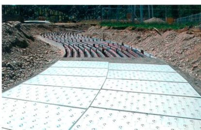
CableMan-Abschirmsystem für Erdkabeltrassen.
