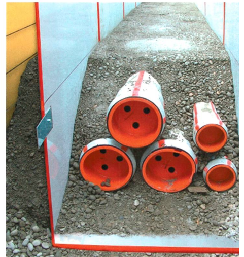
CableMan-Abschirmsystem für Rohrböcke.
