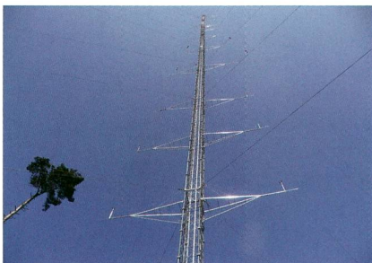
Der Messmast Rödeser Berg ist 200 m hoch und mit mehr als 40 Instrumenten bestückt.
