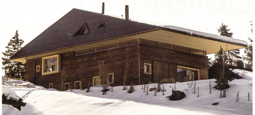
Innovative Netztechnologien ermöglichen einerseits neue Wertschöpfung auf bestehender Infrastruktur. Andererseits helfen sie Netzbetreibern, den sicheren, leistungsfähigen und effizienten Betrieb zu gewährleisten (im Bild ein Gebäude in Sörenberg/LU).
