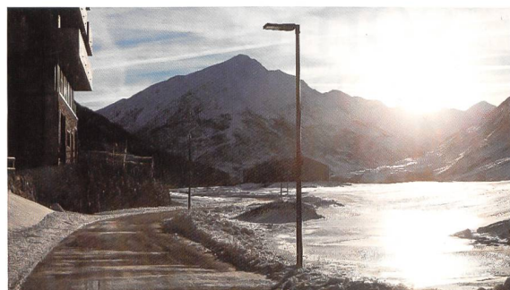
LED-Leuchte BURRI METRO 60 auf Stahlkandelaber (Andermatt Swiss Alps).
