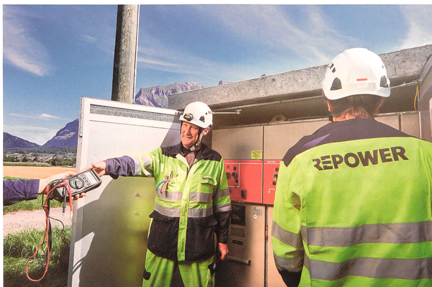
Easyasset eignet sich für alle Arten von Infrastrukturanlagen, die laufend beurteilt und gewartet werden müssen.
