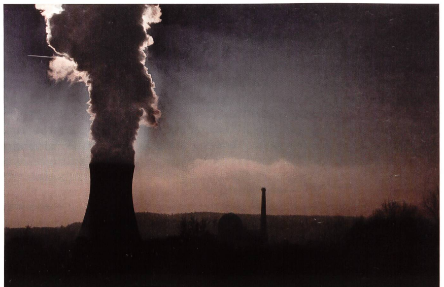
Die Energiestrategie 2050 sieht vor, dass bestehende Kernkraftwerke (im Bild Leibstadt) in der Schweiz vorläufig weiterbetrieben werden dürfen. Neue Rahmenbewilligungen sollen aber keine mehr erteilt werden.
