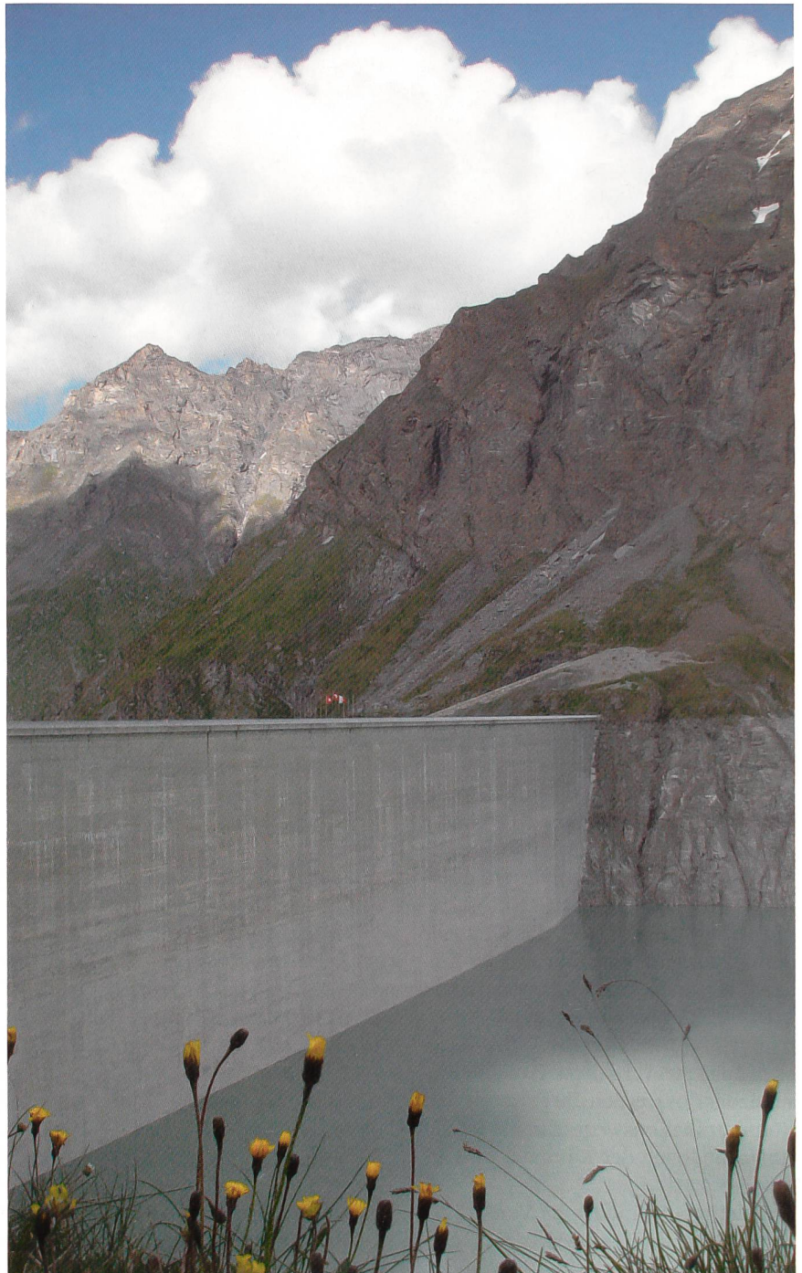
Le barrage de la Grande-Dixence.
