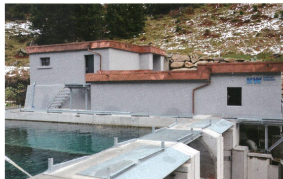
Die neue Wasserfassung des Kraftwerks Gurtellen auf rund 1400 m. ü. Meer.
